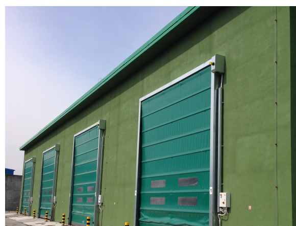
2. BIOCELLA CON TETTO IN CEMENTO
