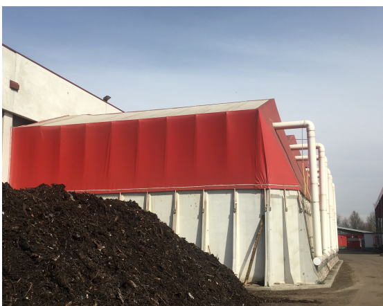
1. BIOCELLA CON TETTO IN PVC
